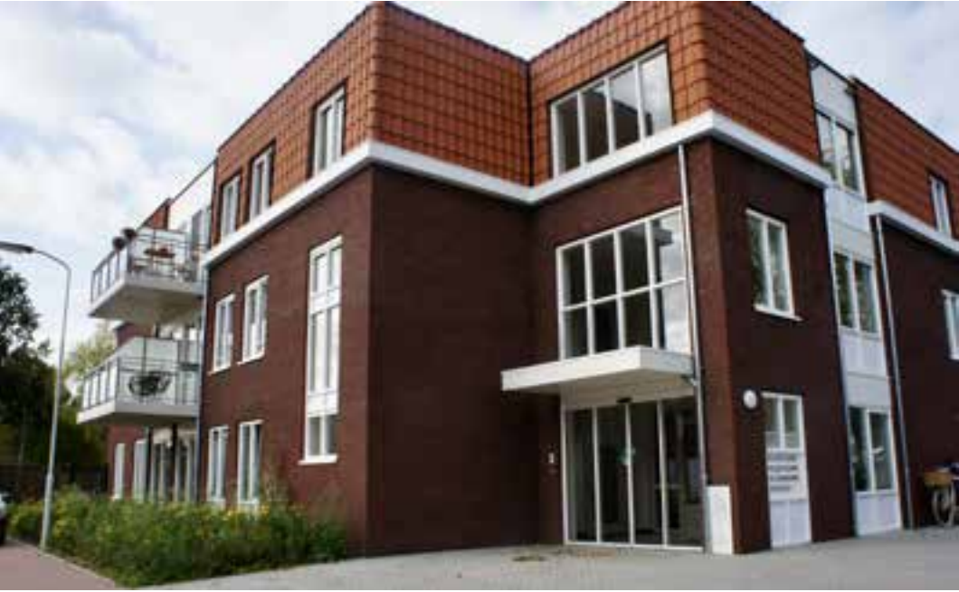
Kom-Fort aan de Rozenstraat: een thuisplek voor negen jongvolwassenen met een verstandelijke beperking.
