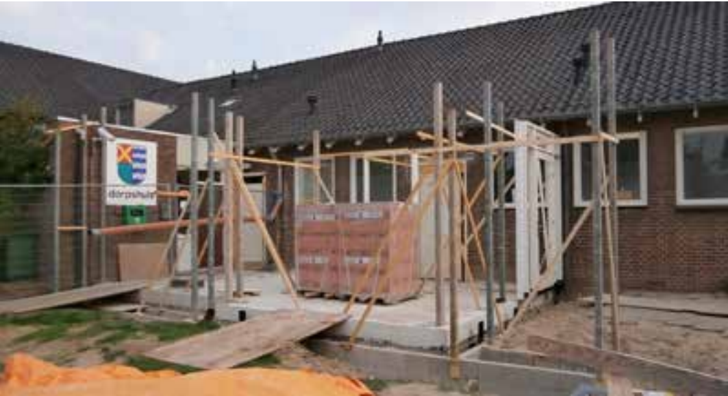
De verbouwing is nog in volle gang.
