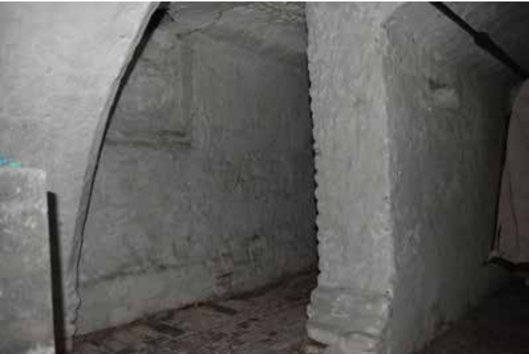
In de kelder, waar grote ronde gewelven en dikke muren zichtbaar zijn, moet ooit een ‘onderdoorgang’ zijn geweest. (foto: Liemers Museum)
