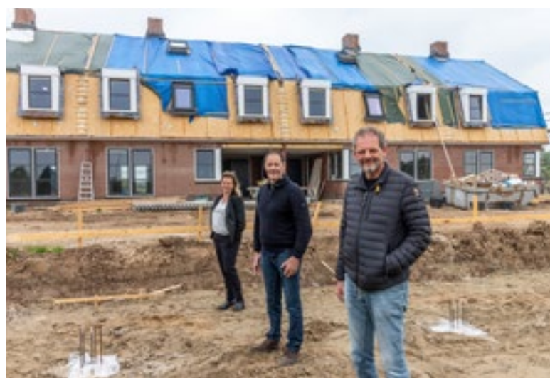
Hans en Rob van Rouwendaal en Berit Simon (GABA) op de bouwplaats waar de laatste woningen van Hof van Hamerden worden gerealiseerd (foto: René Nijhuis Fotografie).
