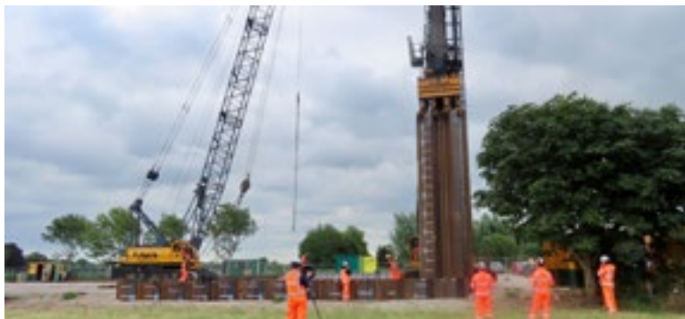
Stukje bij beetje wordt de damwand in de grond geduwd.
